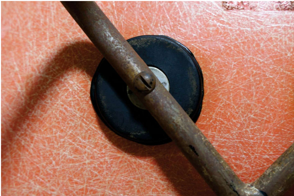
Plate B-06 · Shock Mount detail · 0R9A0586.JPG
